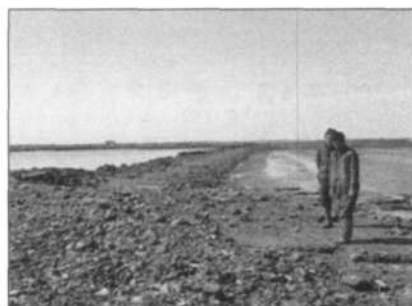
图5b 被浪冲毁的岐口养殖围堤
