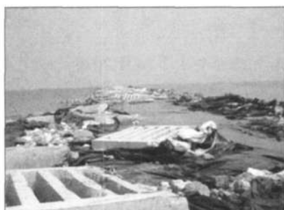
图5a 被浪冲毁的神化电厂南堤墙
