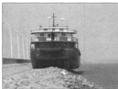
图4b 千吨以上级船舶被浪冲上堤坝
